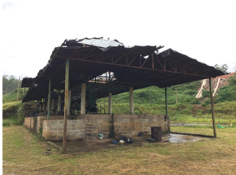
Figura 57 – Unidade de tratamento dentro do aterro sanitário municipal. Fonte – Ambiência, 2019
