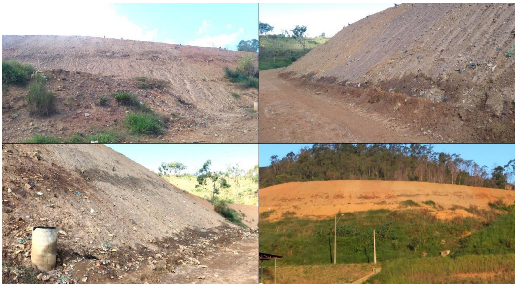
Figura 62 – Pontos de exsudação de chorume nos taludes do aterro sanitário Fonte – CAVO, 2017
